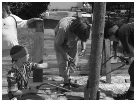
Mit Hammer und Säge wird gearbeitet, bis der Mast fest sitzt.
