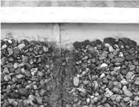
*An den Falzstellen der Blechverkleidung ist die Abdichtung beschädigt: Wasser dringt ins Kirchendach.*
